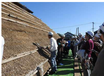
整備工事の様子
