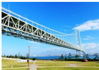
明石海峡大橋
